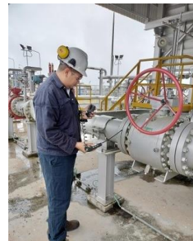
ภาพที่ 2-48 ตรวจสอบการรั่วไหลของท่อโดย Gas detector
