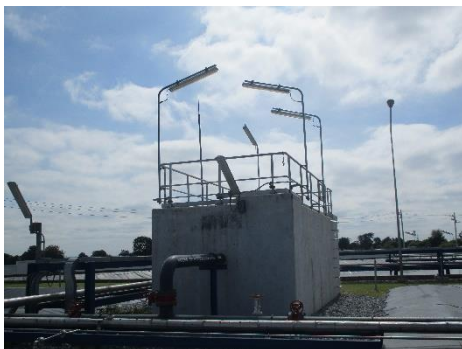
ภาพที่ 2-14 บ่อแยกน้ำ/น้ำมัน (Oil Separator)
