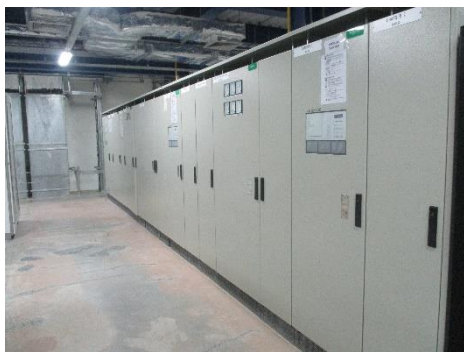
ภาพที่ 2-36 ระบบไฟฟ้าสำรอง
