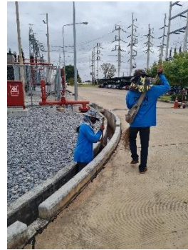
ภาพที่ 2-30 การทำความสะอาดรางระบายน้ำ
